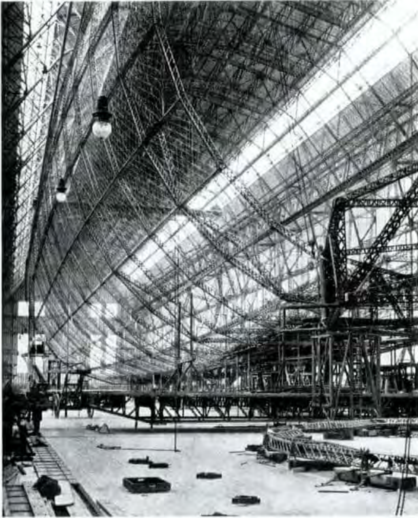
Das Luftschiff-Gerippe im Bau
